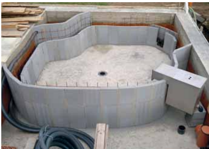
Začiatok výstavby jazierka pripomína obyčajné stavenisko
