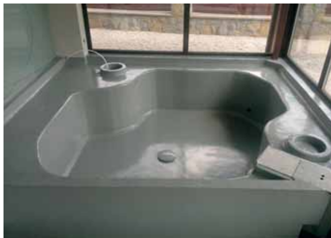
Hydroizolácia vyriešila aj budúce črepníky na výsadbu bonsai
